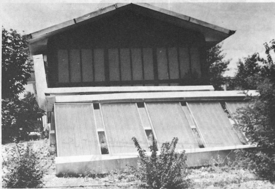
شکل ۱- نمای ضلع جنوبی ساختمان خورشیدی و منظره هواگرم کن ها
